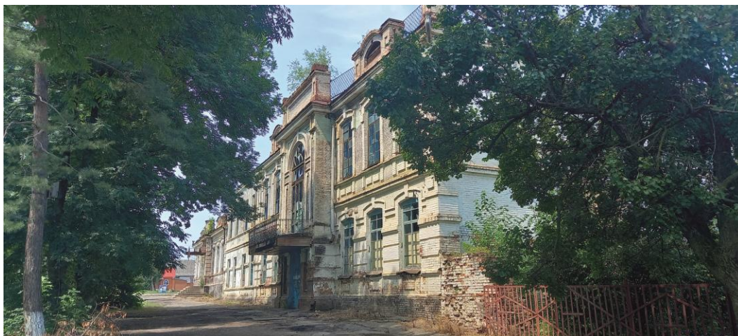
Бывшее здание Ярославского двухклассного училища, построенное в период первого атаманского срока М.А. Тисковского. 9 августа 2021 г. Фото Н.С. Коваленко
